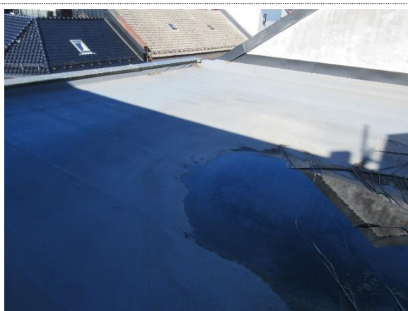
Bilde nr. 51 Sarnafil tekking på deler av taket over 3. et.
