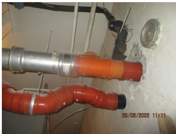
Bilde nr. 55 Nye spillvann og overvannrør ut av bygget.
