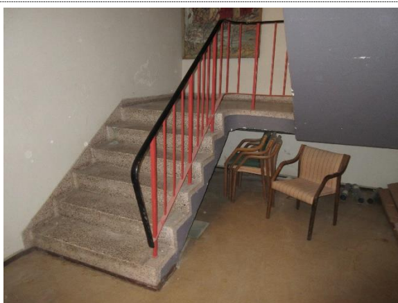
Bilde nr. 47 Trapp med grått Terrazzobelegg.
