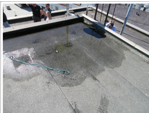
Bilde nr. 50 Konvensjonell papptekking på tak over teknisk rom (6. et.).
