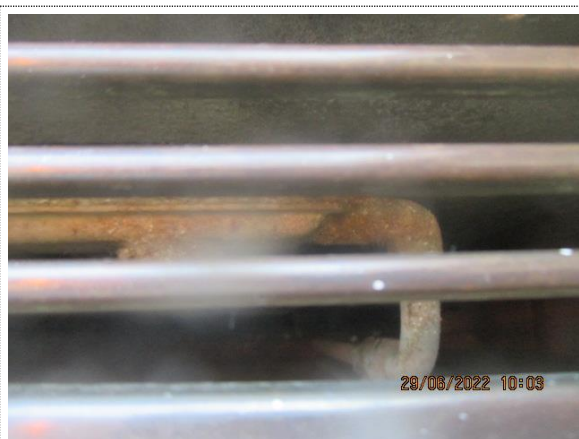
Bilde nr. 67 Rustangrepne radiatorer er innkasset.
