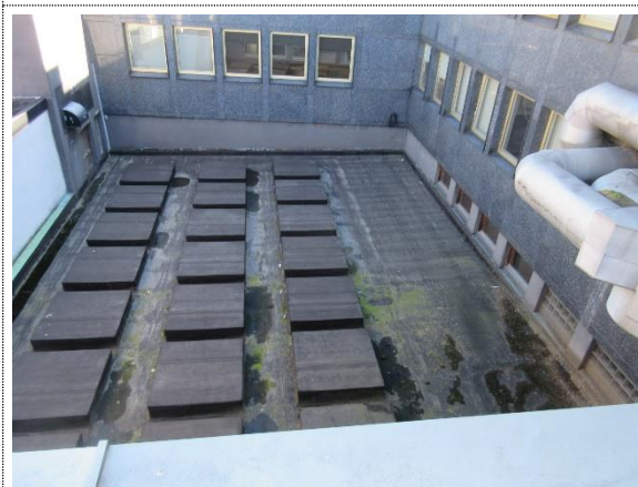
Bilde nr. 52 Derbigum-tekking også over 3. et. Overlys er forblendet.
