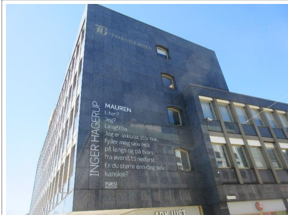
Bilde nr. 10 Fasade mot øst.
