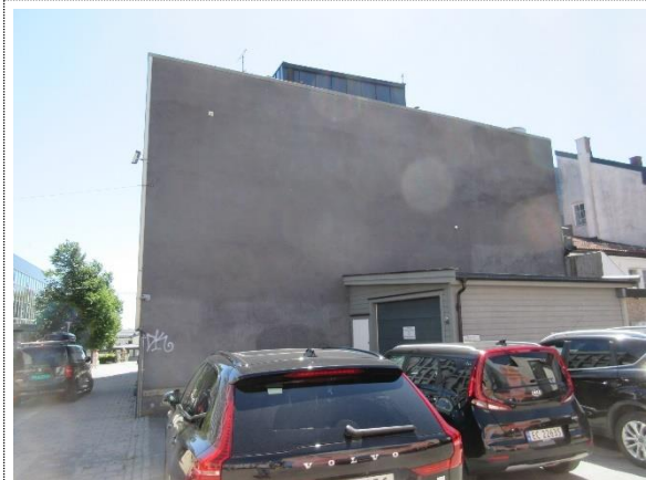
Bilde nr. 12 Gavlvegg mot nord pusset med Mineralux.
