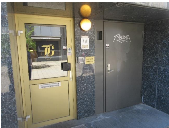
Bilde nr. 11 Aluminiumsdør mot vest fra 1983.
