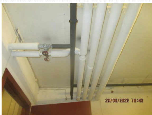
Bilde nr. 65 Gamle varmerør fra 1959 er også modne for utskifting innen kort tid.
