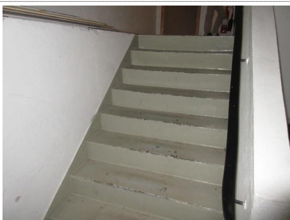
Bilde nr. 45 Malt betongtrapp til kjeller.
