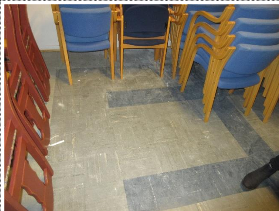
Bilde nr. 44 Gamle vinylfliser fra byggeåret i nedre kjeller. Kan inneholde asbest.
