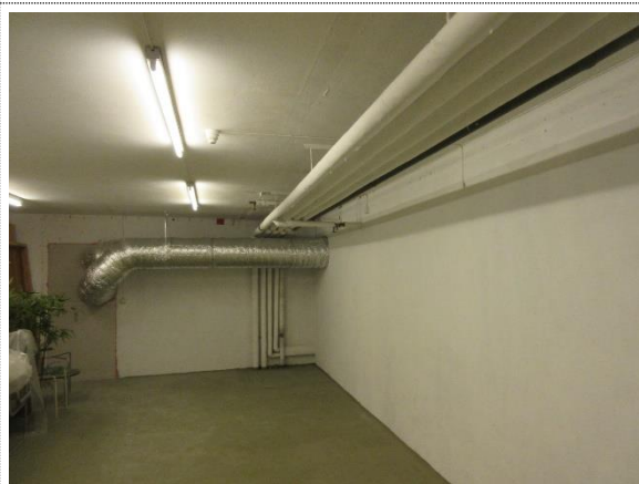
Bilde nr. 35 Tomt lokale i kjeller mot nord.
