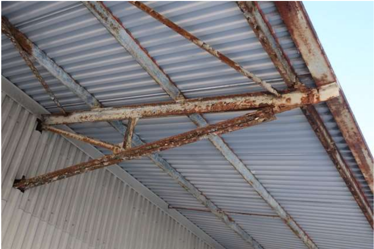
Bilde 31: Bygning, hovedbæring tak
