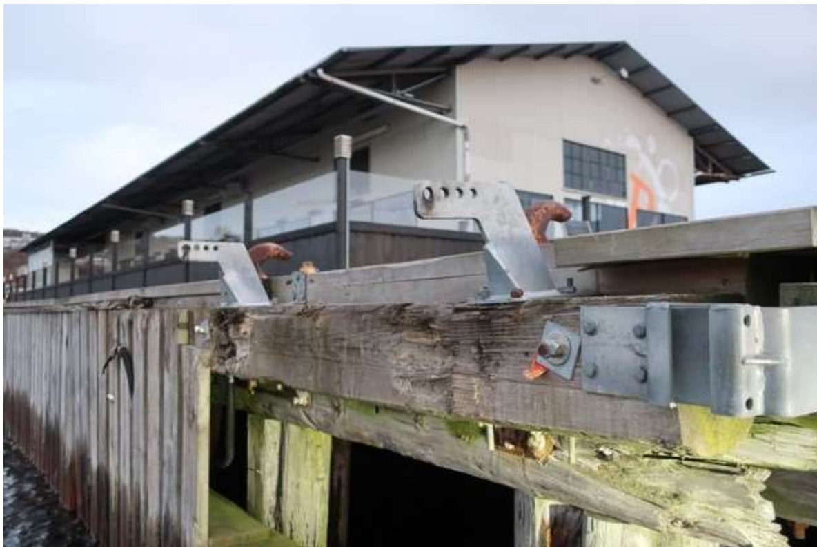
Bilde 20: Flytebrygge, innfestning kaidekke
