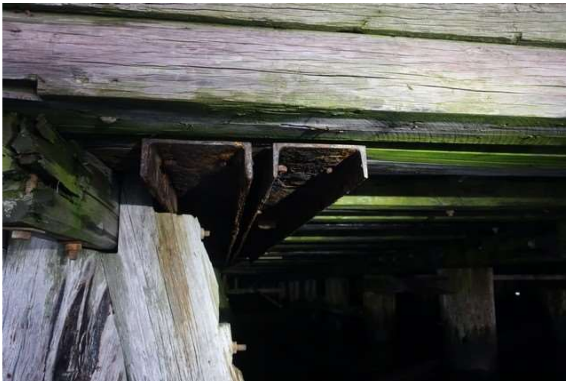
Bilde 27: Fortøyningsutstyr, forankring underkant
