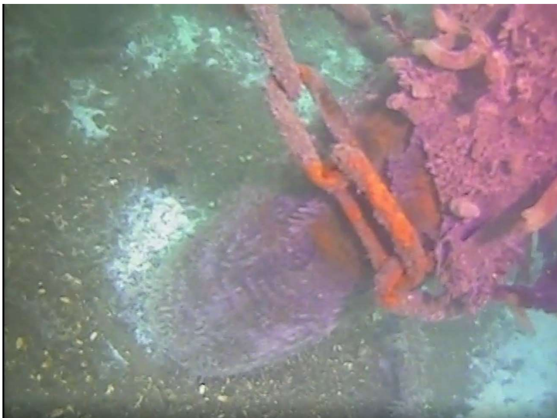
Bilde 21: Flytebrygge, kjetting forankring
