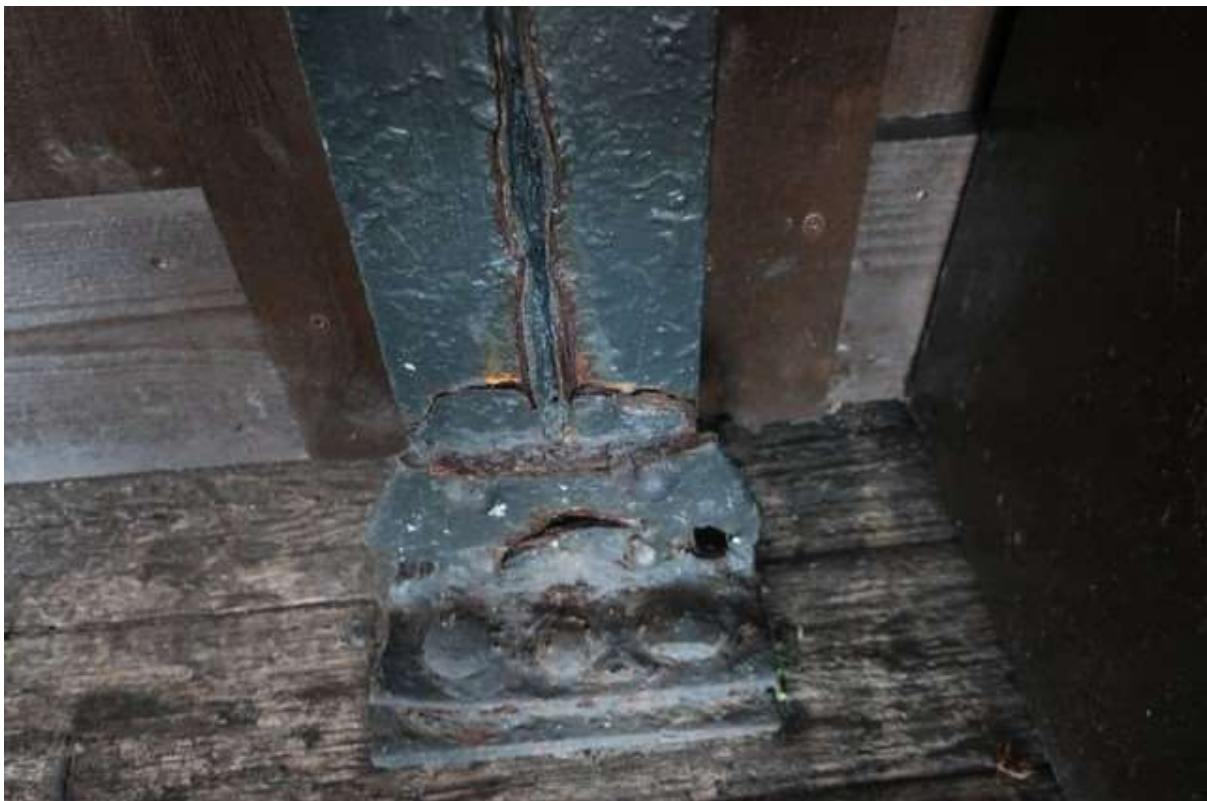
Bilde 32: Bygning, hovedbæring søyler
