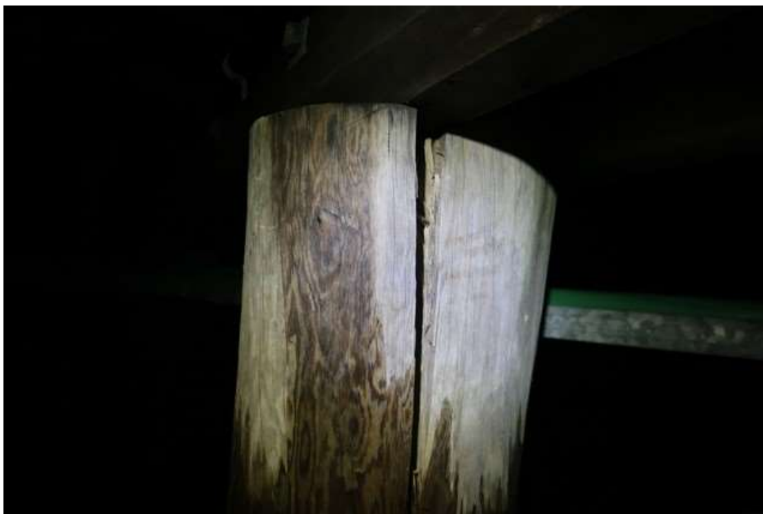
Bilde 5: Pilar, sprekke/brudd i topp
