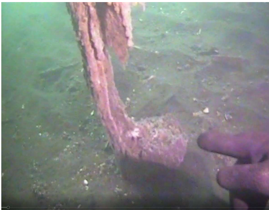
Bilde 3: Pilar, bruddet ved indre del
